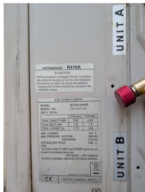
Installation avant retrofit
